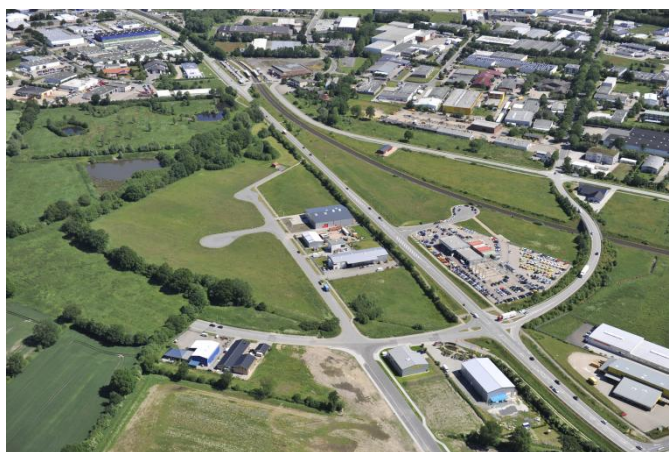
Blick von Süden auf das B-Plangebiet Nr. 61 „Westerwohld Nord“
