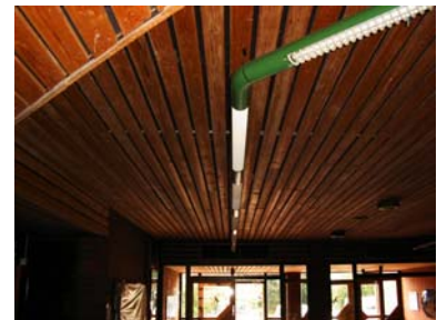
Decke vor der Sanierung
