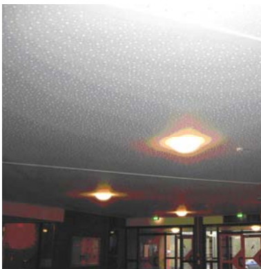
Decke nach der Sanierung
