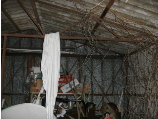
Abb. 2: Schuppen / Garage von Norden
