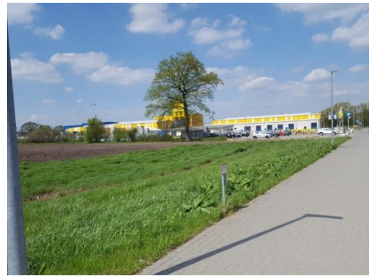
Abb. 8: Nördlicher Knick mit angrenzendem neuen Gewerbe
