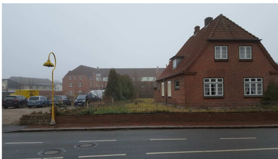
Abb. 4: Gebäude, Blick von Osten
