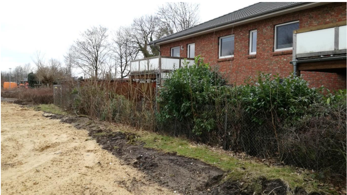
Abb. 8: Angrenzende Wohnbebauung mit Ziergehölzen im Nordosten
