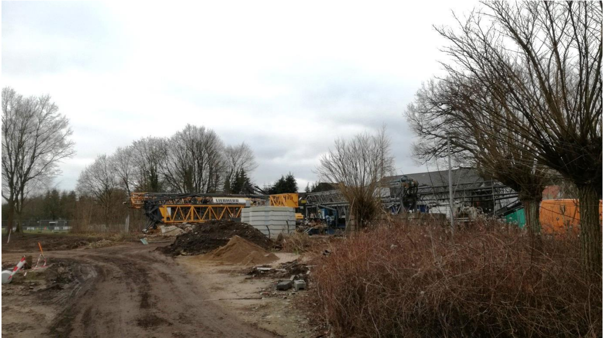
Abb. 7: Kopfbäume und Ziersträucher zwischen Parkplatz und Baustelle, die nicht erhalten werden
