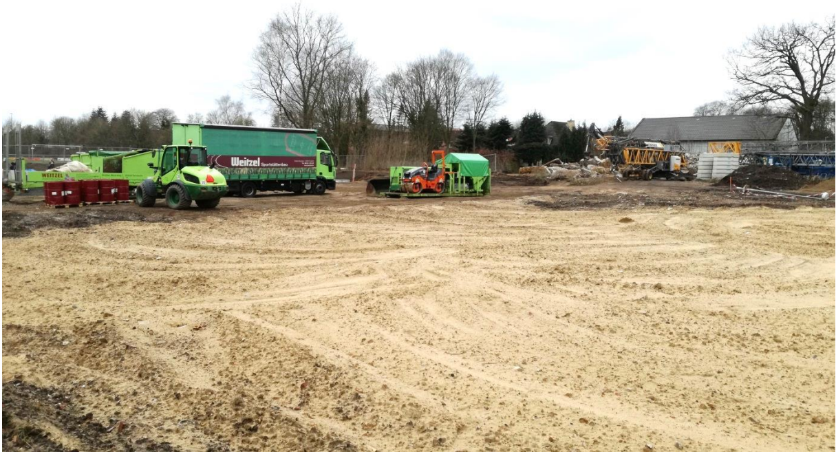
Abb. 9: Entfernte Gebäudebereiche, derzeit Baustelle
